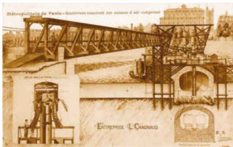
« Fonçage » des caissons pour la traversée sous-fluviale de la ligne 4.
